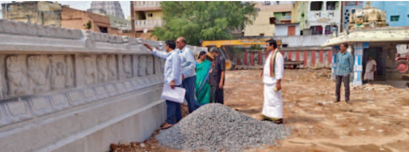
ఆలయ పనులను పరిశీలిస్తున్న ఇంజనీరింగ్ అధికారులు,చైర్మన్ శ్రీనివాసులు
